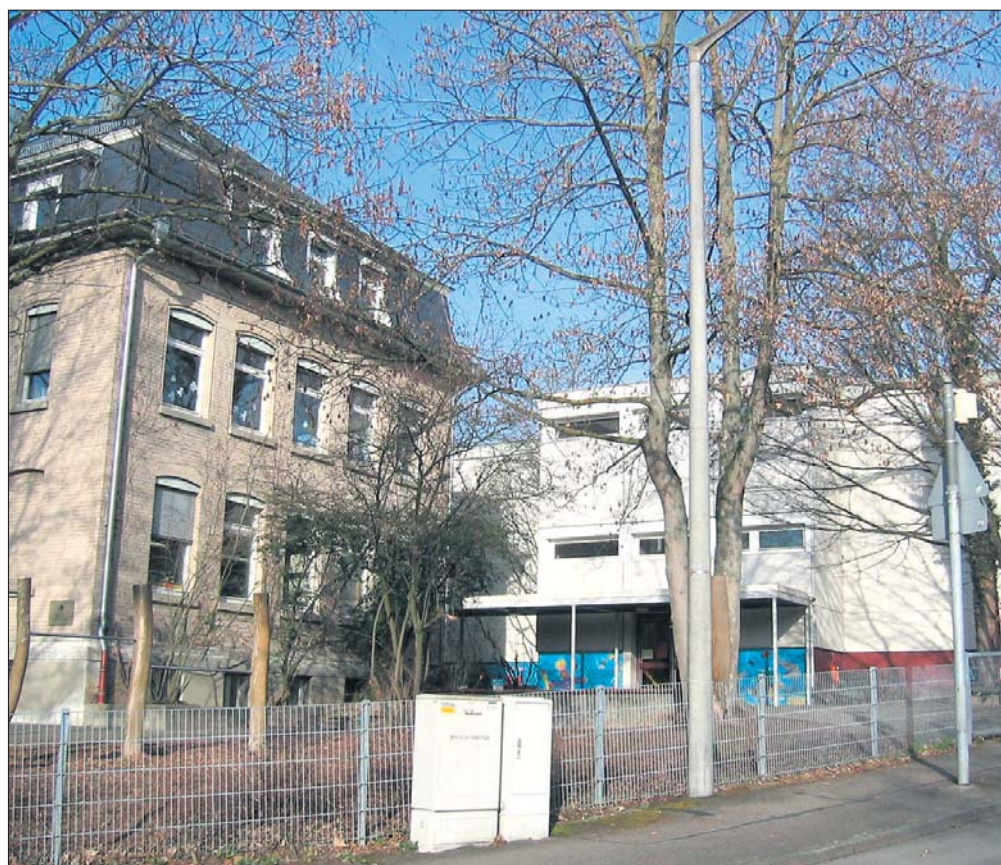
Der schadstoffbehaftete Schulpavillon (rechts) sollte schon Ende vergangenen Jahres abgerissen werden. Das Bebauungsplanverfahren läuft noch, eine Baugenehmigung liegt noch nicht vor. Im Sommer soll der Abriss starten. Foto: Frey
